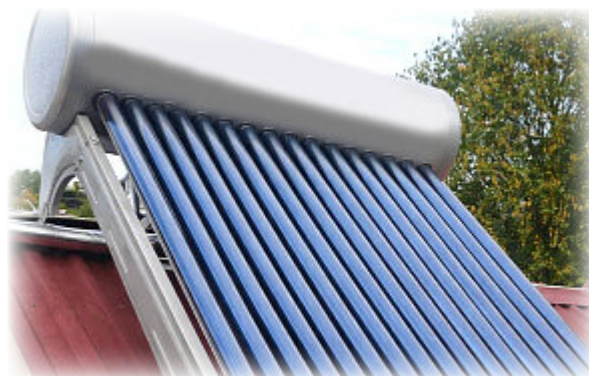
Рис. 18. Солнечный коллектор на крыше здания
