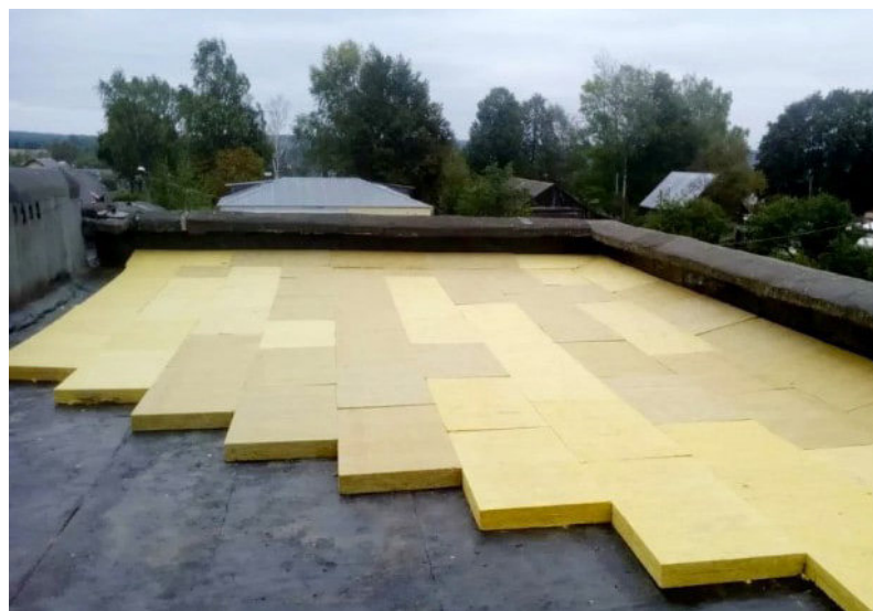
Fig. 2. Termoizolarea acoperișului și a planșeelor spre pod
