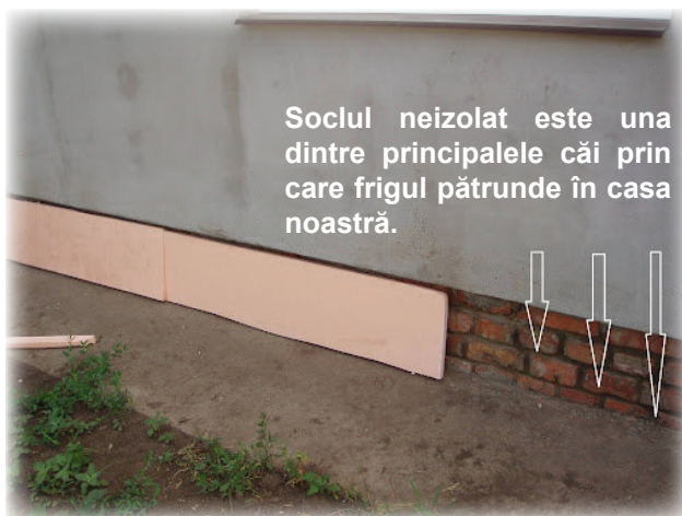
Fig. 4. „Punți termice”: a – colțurile clădirii; b – zona de soclu a peretelui clădirii
